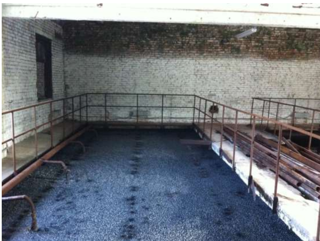
Рис.2.1.2.1.Существующее состояние аэротенков на территории очистных сооружений.
