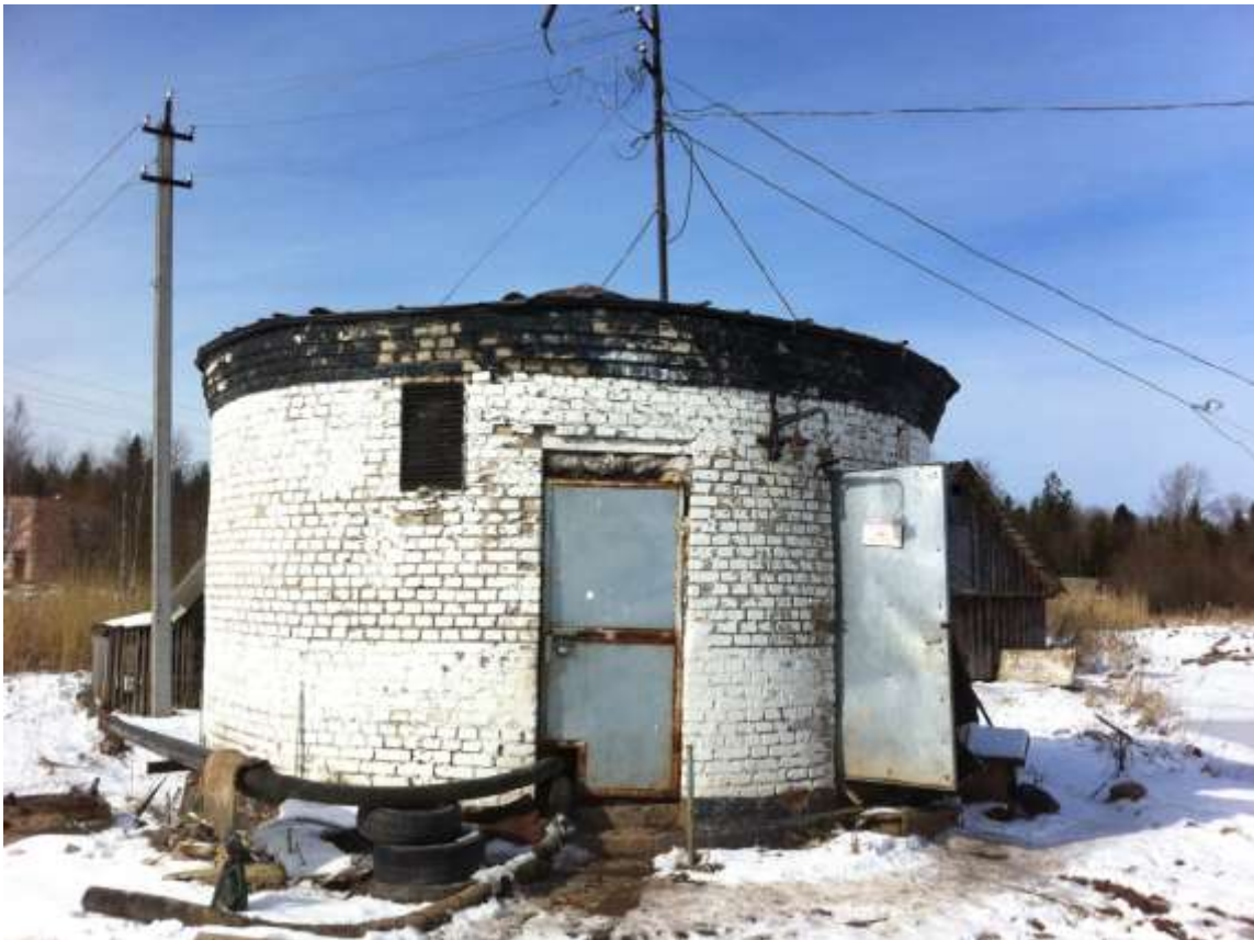
Рис.2.1.2.3. Существующее состояние канализационной насосной станции (КНС)
